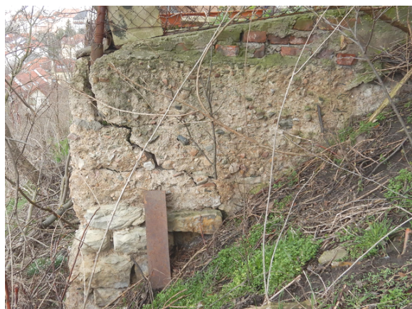
Obr. 5: Výskyt trhlin
