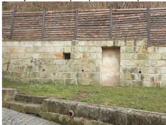
Obr. 11: Zazděný vstup v opěrné zdi
