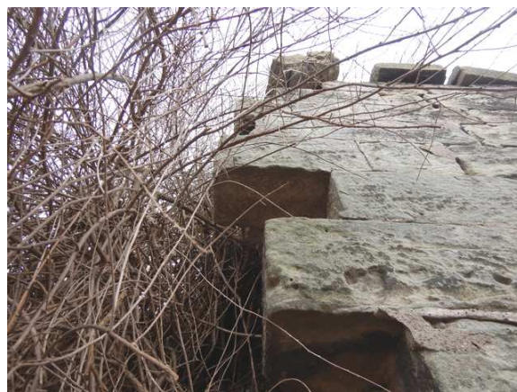
Obr. 3 a 4: Rozpadlý roh zdi, hrozící pád kamenů
