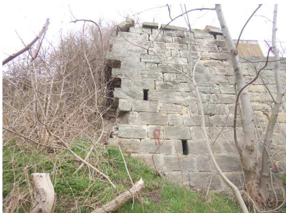
Obr. 3 a 4: Rozpadlý roh zdi, hrozící pád kamenů
